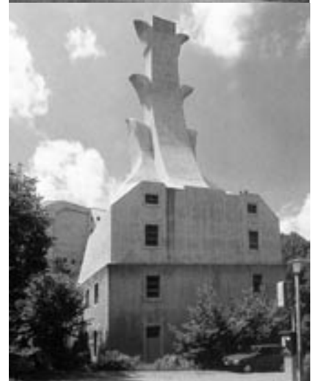
Konsequenterer Ansicht des Heizhauses, Heizhaus zum Goetheanum
