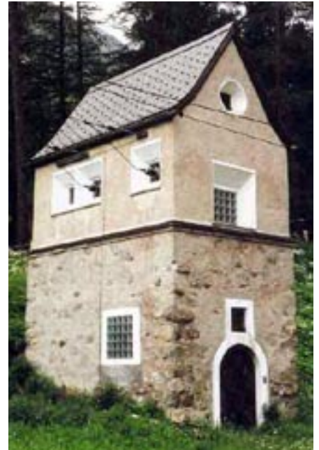
Transformatorernturm in Spinas, Schweiz
