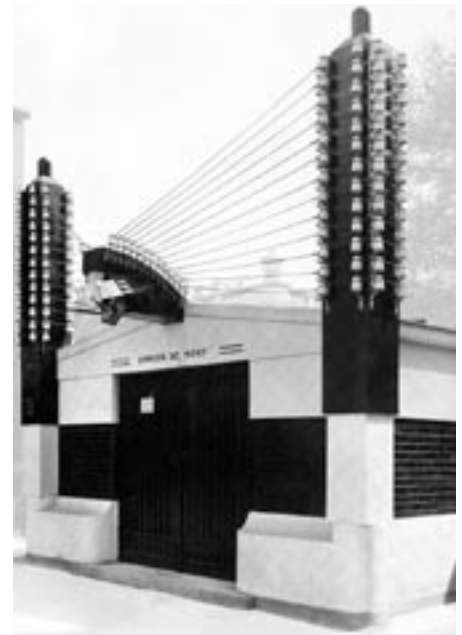
Transformatorstation, Einkaufsgalerie im Hintergrund links
