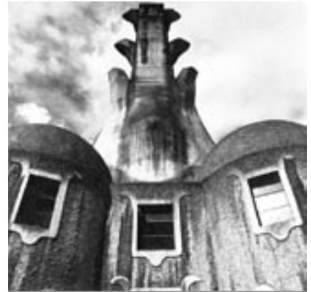
Schornstein vom Vorplatz, vor dem Verputz
